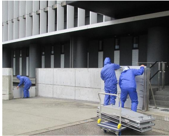
止水板設置箇所は6箇所あるため、分かれて一斉に作業実施
