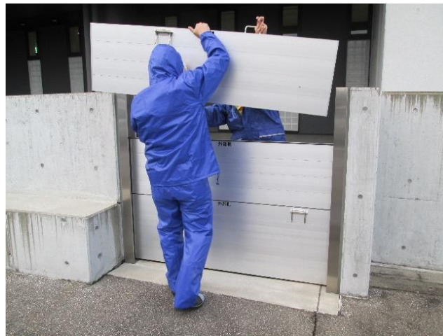
止水板設置箇所は6箇所あるため、分かれて一斉に作業実施
