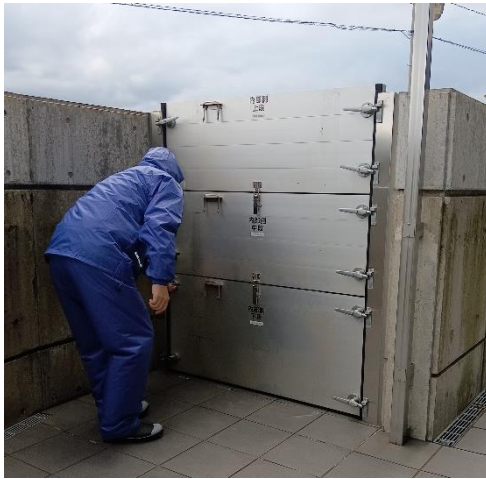
止水板設置箇所は6箇所あるため、分かれて一斉に作業実施
